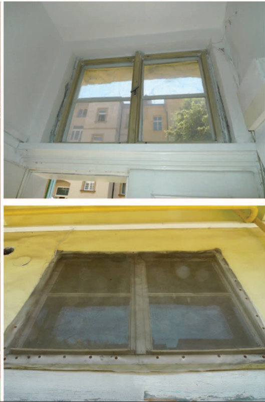
O/2 nadsvětlové okno nade dveřmi D/1 z vnější strany je přibitá síť proti hmyzu
