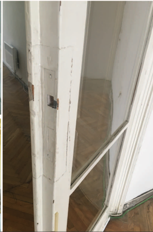
D/2 detail uložení novodobého kování
