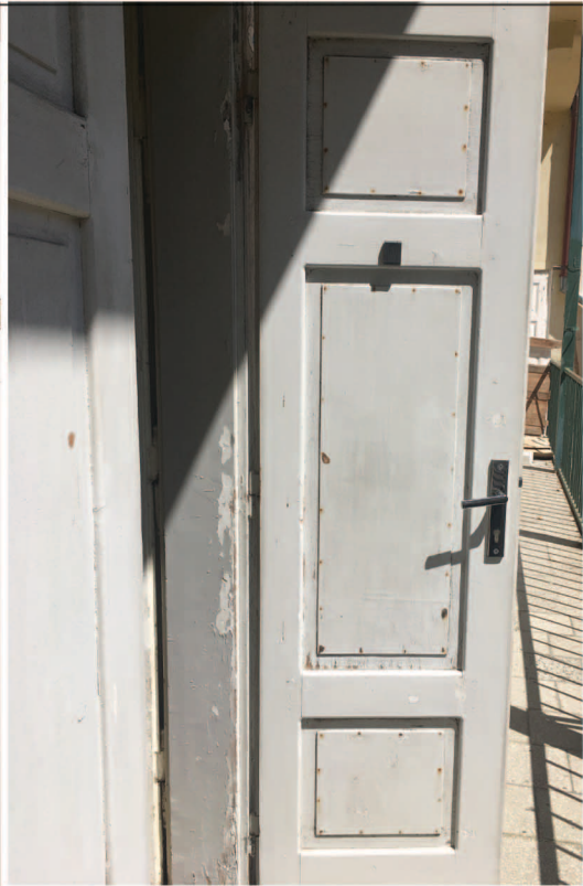
D/1 dveřní křídlo vnějších dveří kazety jsou obloženy překližkou
