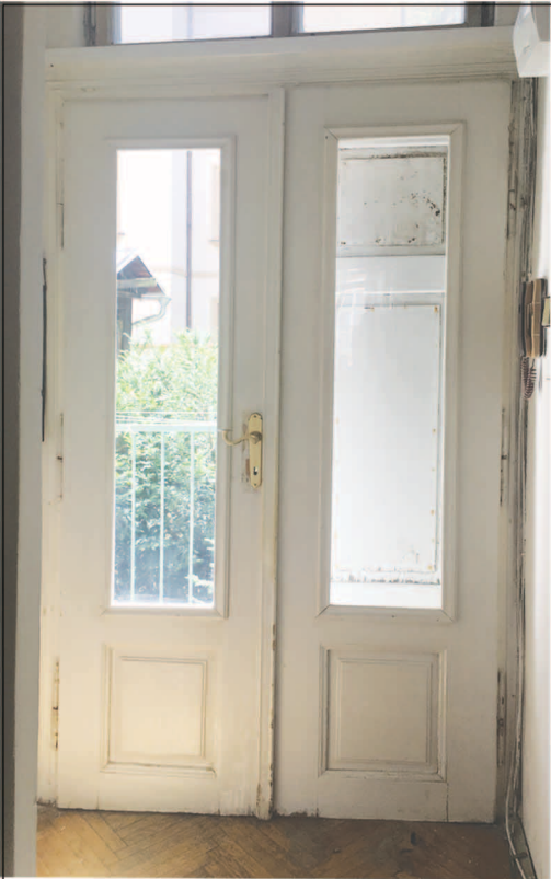
D/1 Velikost 1200 x 2150 (2190) Vstupní dvojité dveře dvoukřídle, dřevěné s nadsvětlovým oknem. Vnější dveře novodobé dřevěné dvoukřídle, otvíravé, kazetové, plné. Výplň kazet je odplněna o překližkové obložení. Vnitřní dveře novodobé kazetové dřevěné, prosklené. Nadsvětlik - novodobé šroubované dvoukřídle otvíravé okno z vnější strany chráněno sítí proti hmyzu. Zárubeň - dřevěná obložková zárubeň, na vnitřní straně s dobovou profilací, na vnější straně byla profilace předělána na hladkou. Povrchová úprava - nátěr bílý Kování - panty původní, novodobý zámek klika klika
