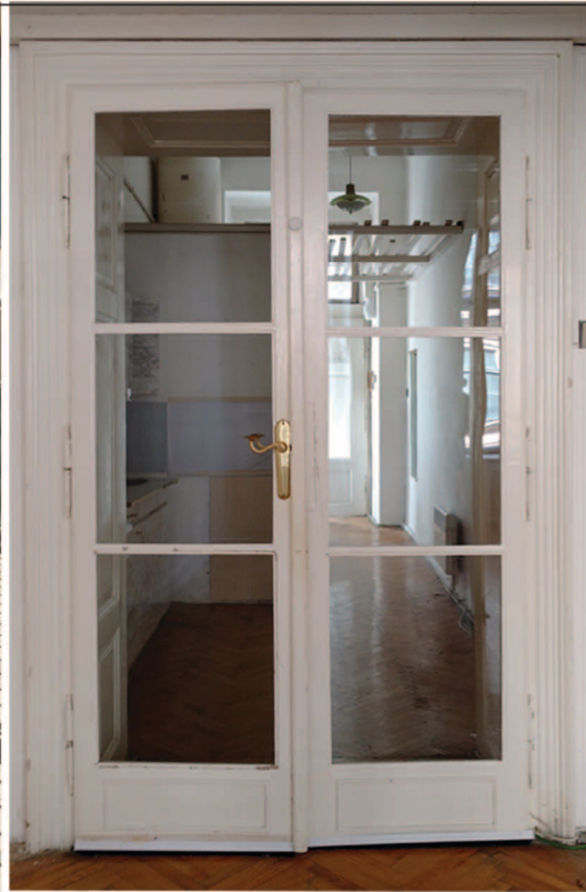
D/2 Velikost 1190 x 2190 Vnitřní dveře dvoukřídle, otvíravé, dřevěné, prosklené. Zárubeň - dřevěná obložková zárubeň s profilací včetně kazetového obložení stěn Povrchová úprava - nátěr bílý Kování - novodobý štítkové kování klika klika
