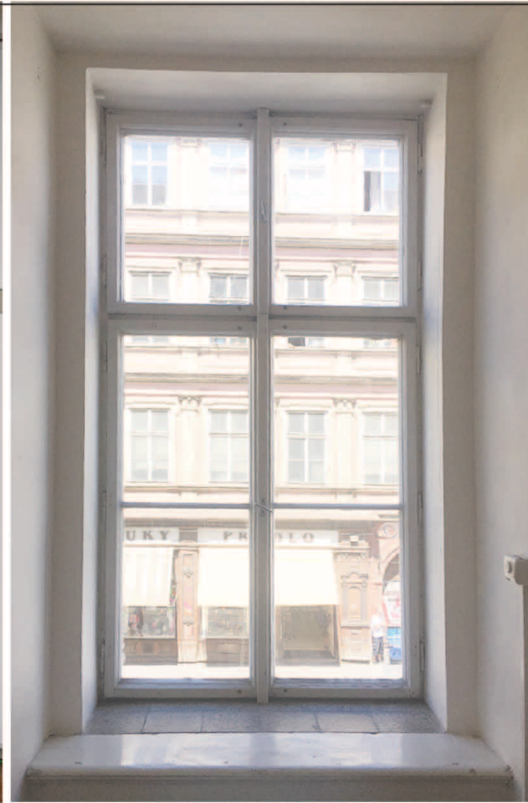
O/1 Velikost 1260 x 2400 Zdvojené (šroubované) dřevěné, otvíravé okno. Velikost a umístění je podle původního dobového dvojitého okna. Okenní křídlo - dřevěné, zdvojené, dvoukřídle, otvíravé. Kování - novodobé hliníkové okenní klíčky. Vnitřní parapet - obložen teraco dlaždicemi, parapetní deska má dřevěné kazetové obložení, náter bílý
